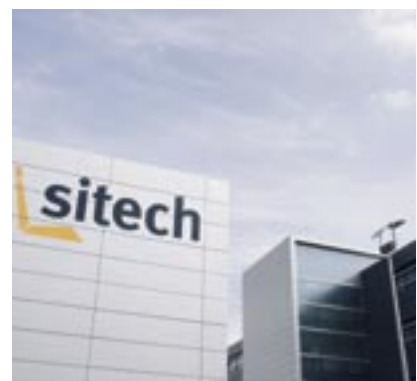
Außenansicht der Sitzmontagehalle bei Sitech.
