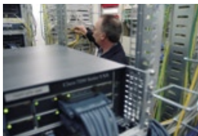
WOBCan Netzknotten – hier laufen die Datenverbindungen zusammen
