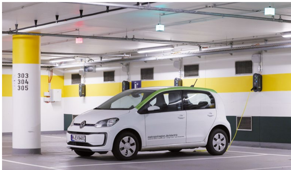
LED-Würfel in der Tiefgarage im Rathaus zeigen Belegstatus von Parkplätzen
