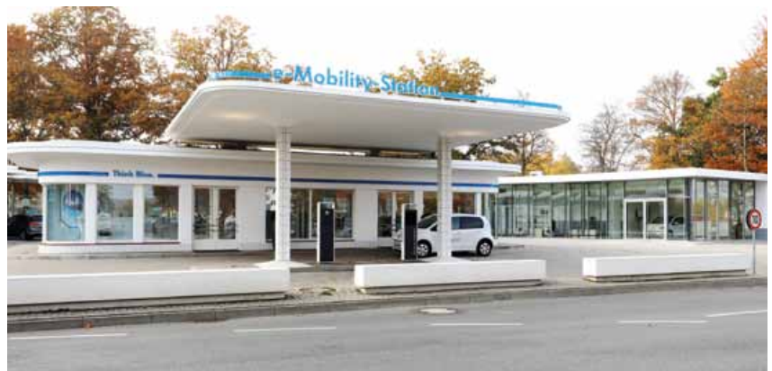
Mobilität der Zukunft – sichtbar an der Braunschweiger Straße
