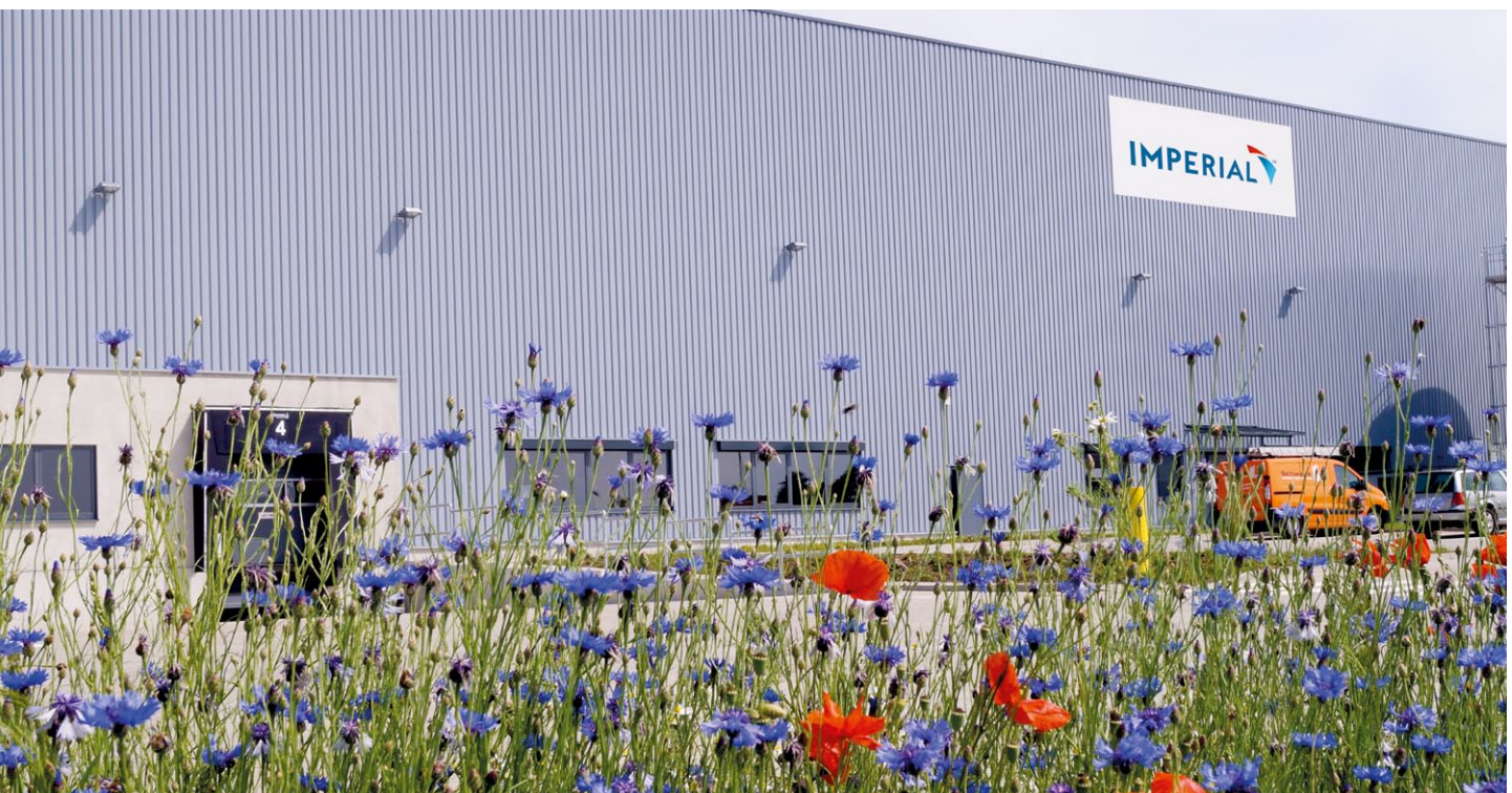
Das Automatische Kleinteilelager von Imperial in Flechtorf bei Wolfsburg
