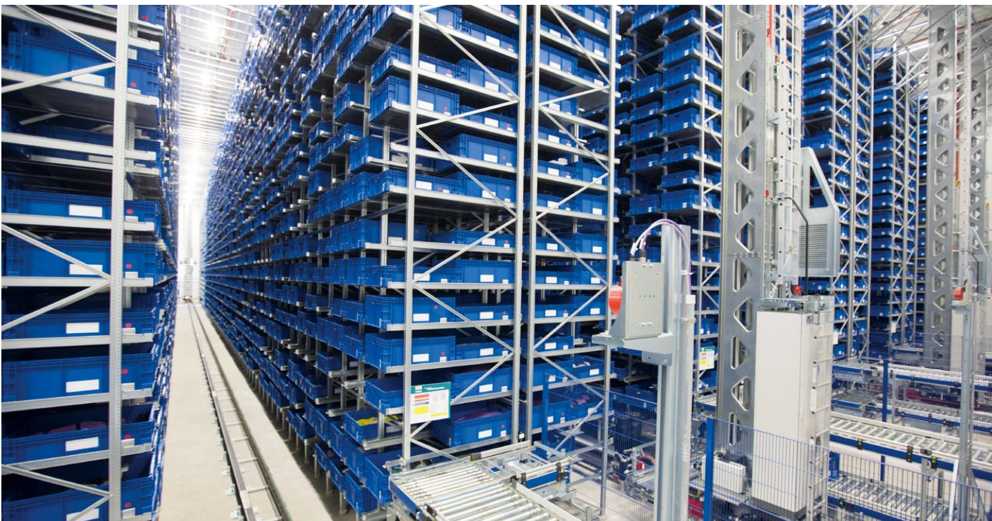
Pro Behälter ein Kabelsatz: Im Automatischen Kleinteilelager von Imperial in Flechtorf warten die Behälter auf den Abruf aus dem Volkswagenwerk.
